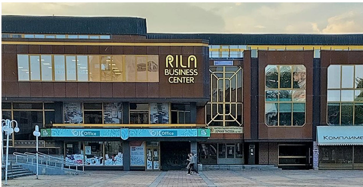
Общ изглед на бизнес център Рила
